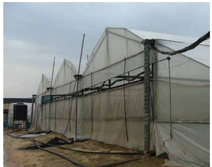
Invernadero de tomates. Aspersores 501 en el techo a lo largo de los canales
